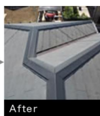
【板金屋根】 風災で痛んでしまった貫板と棟板金を全て新しいものに交換し、釘の頭をシーリング処理しました。
