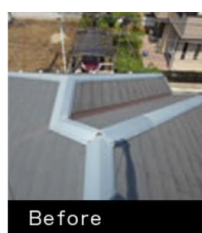
【板金屋根】 風災で痛んでしまった貫板と棟板金を全て新しいものに交換し、釘の頭をシーリング処理しました。
