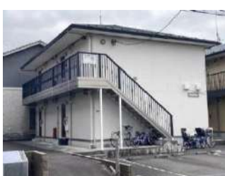
パナソニックホームズ施工 全4戸+駐車場3台 2018年4月外壁塗装済み
