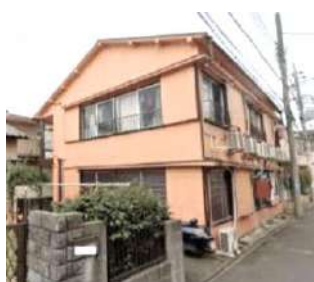
2017年に大規模修繕済 外壁塗装・屋根をスレートへ
